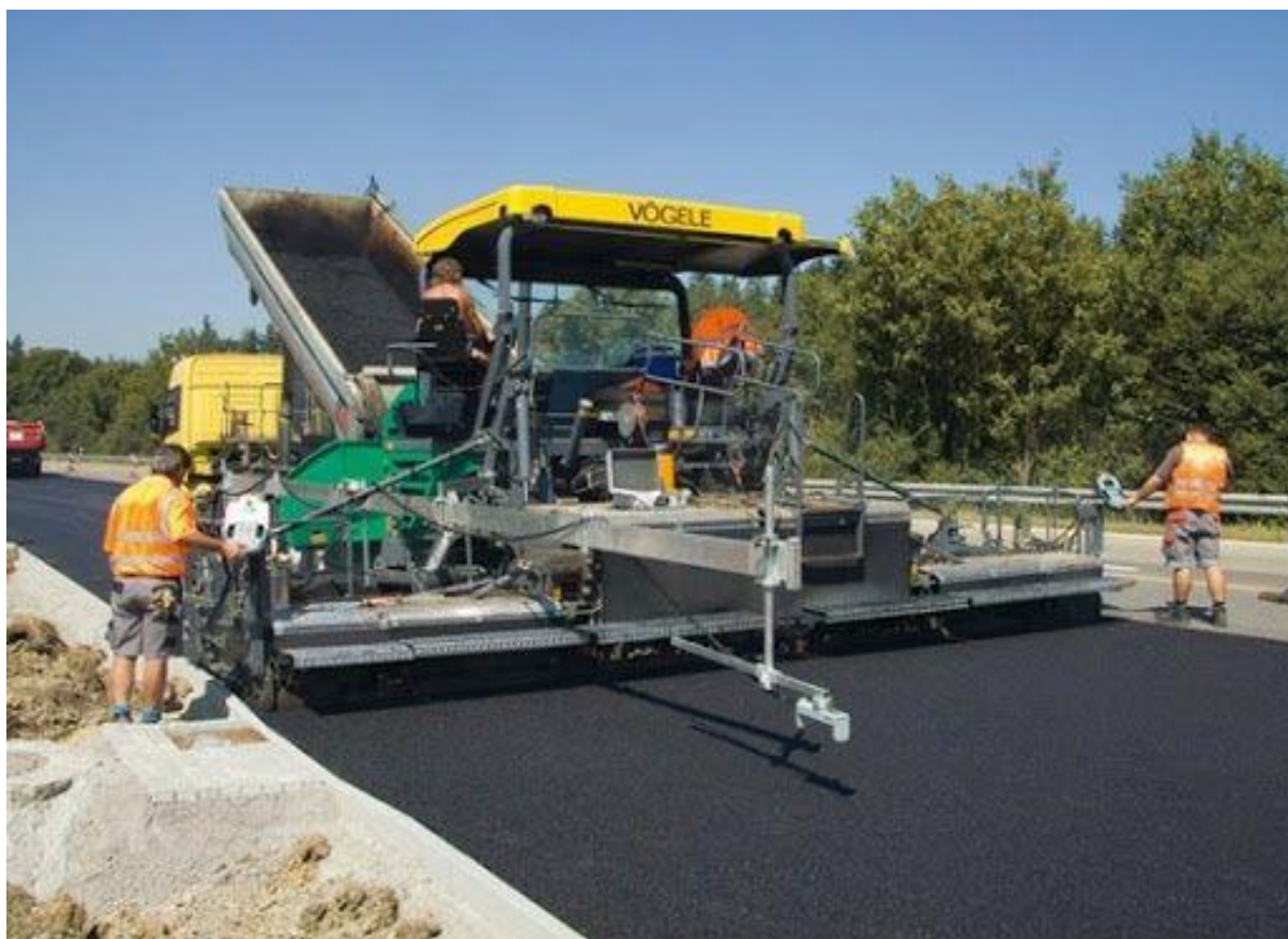
Рисунок 4 – Роботизированные системы для укладки асфальта
